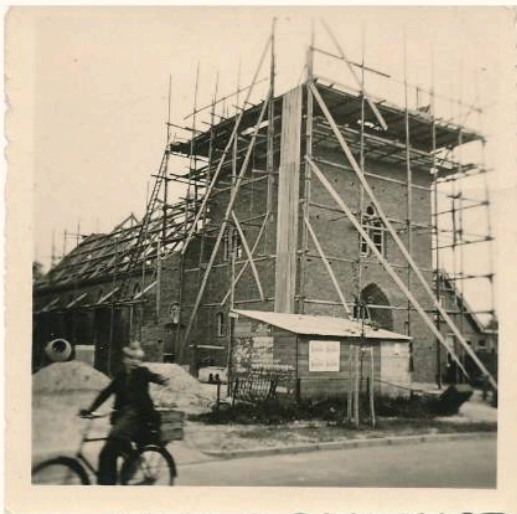
Fredrikskerk in aanbouw 1950
