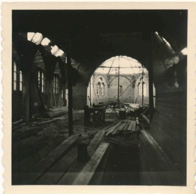
Interieur in aanbouw 1950
